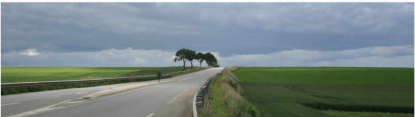
Le passage de la RD939 au cœur d'un paysage agricole (vue depuis l'est de Haute-Avesnes)
