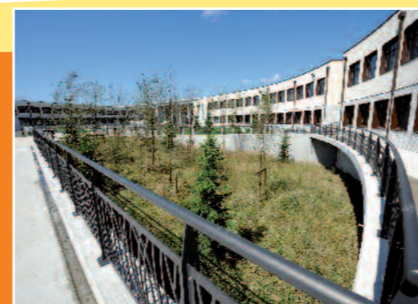
> Collège Denis Diderot à Dainville
